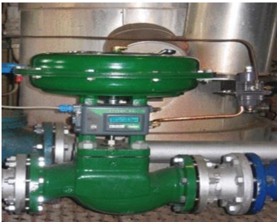
10 Сурет – Мембраналы пневможетек
